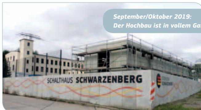
Aus 44 vorbereiteten Fertigteilen wird die Gebäudehülle des neuen Schalthauses zusammengesetzt. Diese werden verbunden und abgedichtet. Ein Doppelboden im Inneren entsteht und die Wände werden innen und außen gemalt.
