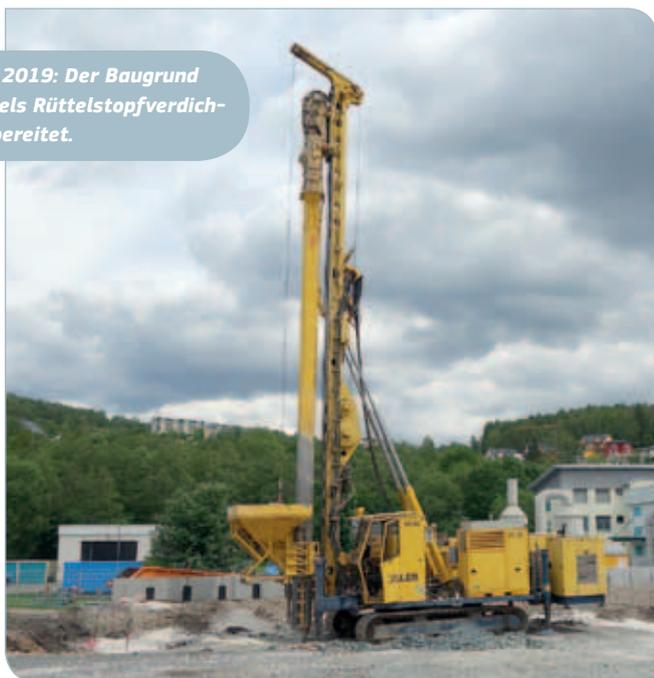
Auf der Fläche, auf der später die Bodenplatte gegossen wird, werden 79 Säulen fünf bis sechs Meter tief in die Baugrube eingebracht. Diese sogenannte Rüttelstopfverdichtung erhöht die Tragfähigkeit des Baugrunds. Ein Rüttelgerät verdrängt das Erdreich zur Seite. In die entstandenen säulenförmigen Hohlräume werden Kies oder Schotter gefüllt und zusammengespresst.
