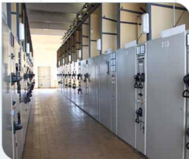
*Im alten Schaltheus fanden 26 Mittelspannungs-Schaltzellen über 2 Etagen mit je 190 m<sup>2</sup> Platz. Sie waren luftisoliert. Diese Methode war platzaufwendig.*
