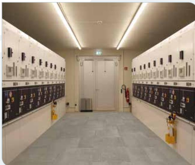
*Im neu gebauten Schaltheus benötigen 24 Mittelspannungs-Schaltzellen gerade mal 52 m<sup>2</sup>, plus 35 m<sup>2</sup> für die Warte. Grund dafür ist die moderne Gasisolation. Diese bietet neben der platzsparenden Bauweise auch einen höheren Schutz und einen geringeren Wartungsaufwand.*
