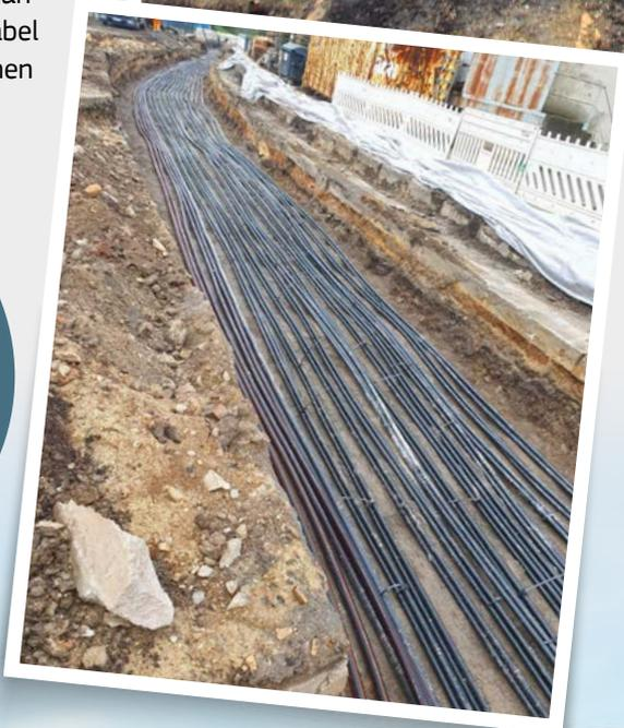
Nachdem die tonnenschweren Betonplatten abgehoben und die alten Kabel rausgeholt wurden, verlegte man entlang der Straße Am Wasserwerk insgesamt 10 Kabelsysteme: Das sind fast 11 km Leitungen! Als letzter Schritt wurde der Netzknoten zur Leittechnik umgebunden. Dann konnte das alte Schaltheis am 14.10.2021 komplett außer Betrieb genommen werden. Nun steht das neue Schaltheis für die nächsten 40 Jahre Versorgungssicherheit für Schwarzenberg.
