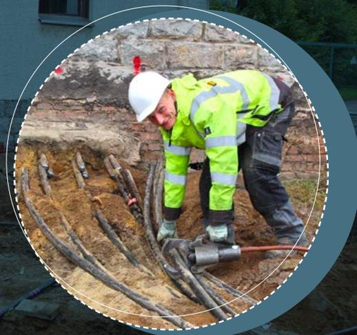
Was aussieht wie „Kabelsalat“ hat System: Vom Umspannwerk liefern Trassen (ein Verbund mehrere Stromleitungen) zum Schalt haus der Mitnetz und zu unserem alten Schalt haus. Diese Kabel mussten auf das neue Schalt haus umgebunden werden. Hier schneidet Stadtwerke-Monteur Max Poppe gerade die nicht mehr benötigten Kabel des alten Schalt hauses ab.
