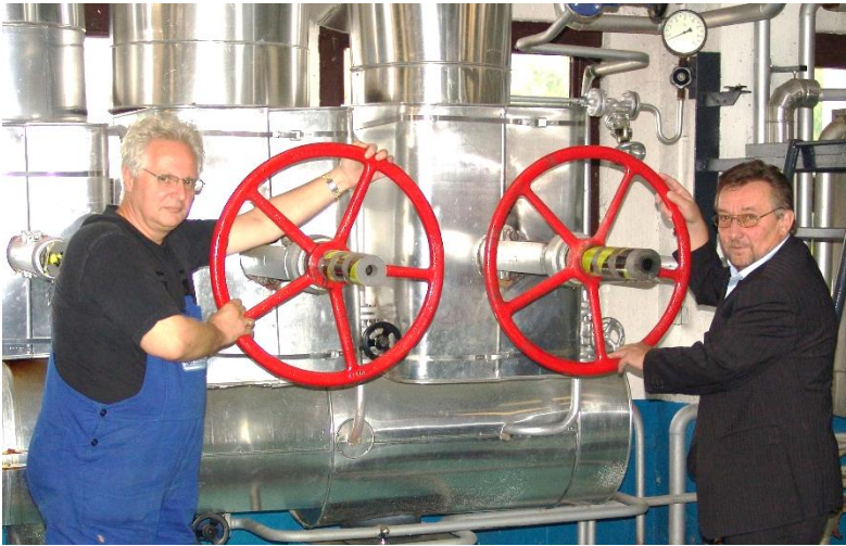
5 Die Außerbetriebnahme der technischen Anlagen im Heizkraftwerk Neuwelt durch Monteur (links) und Geschäftsführer Herr Kühnscherf (rechts)
