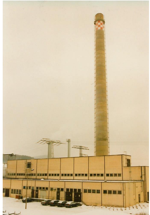
4 Das Heizkraftwerk in Neuwelt mit dem charakteristischen hohen Schornstein
